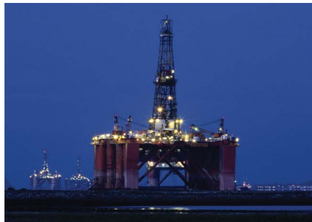
Plataforma petrolera del Mar del Nord
